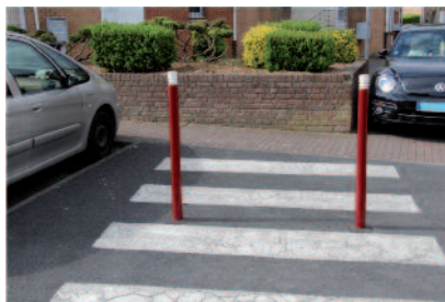
Sécurisation du passage piéton Rue Albert Poutrain
