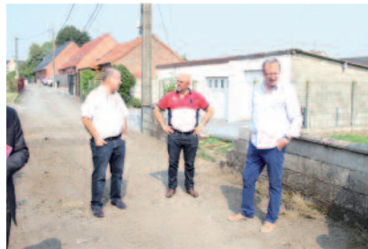
Travaux de réfection des réseaux Sentier de la Poste
