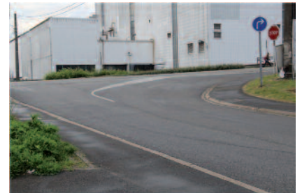
Réfection de la voirie Carrière Tockaert
