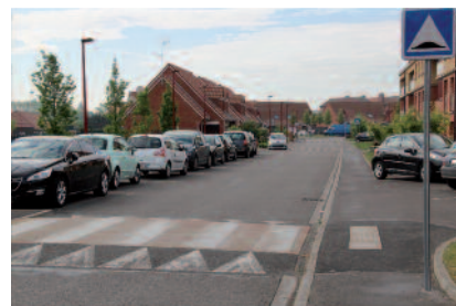
Mise en place d'un ralentisseur Rue des Bleuets
