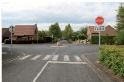
Mise en place de 4 STOPS rue Victor Delannoy - rue du Collège
