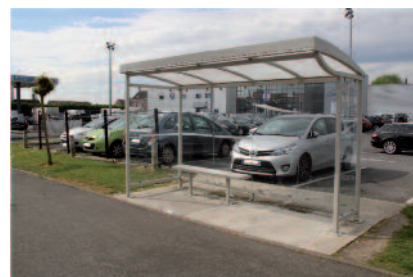
Mise en place d'un aribus
