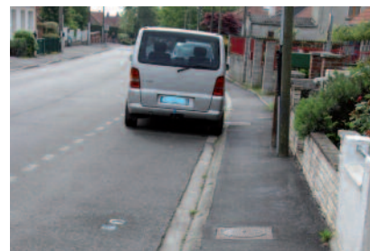
Réfection du trottoir Rue Victor Delannoy
